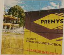
DÉMOLISSEUR. C'est la société Premys qui conduit ce chantier de démolition. Photo: Corinne Garay
