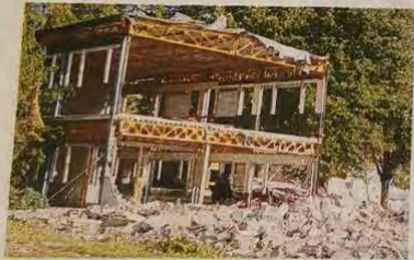
L'AGLCA. La maison des sociétés désamiantée est littéralement coupée en deux. Il ne reste ici que le spectre des centaines de millions d'heures de réunions qui s'y sont tenues. Photo: Corinne Garay
