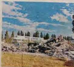
ET APRÈS ? Une fois les derniers gravats ôtés, le nouveau programme immobilier va pouvoir commencer. Photo: Corinne Garay
